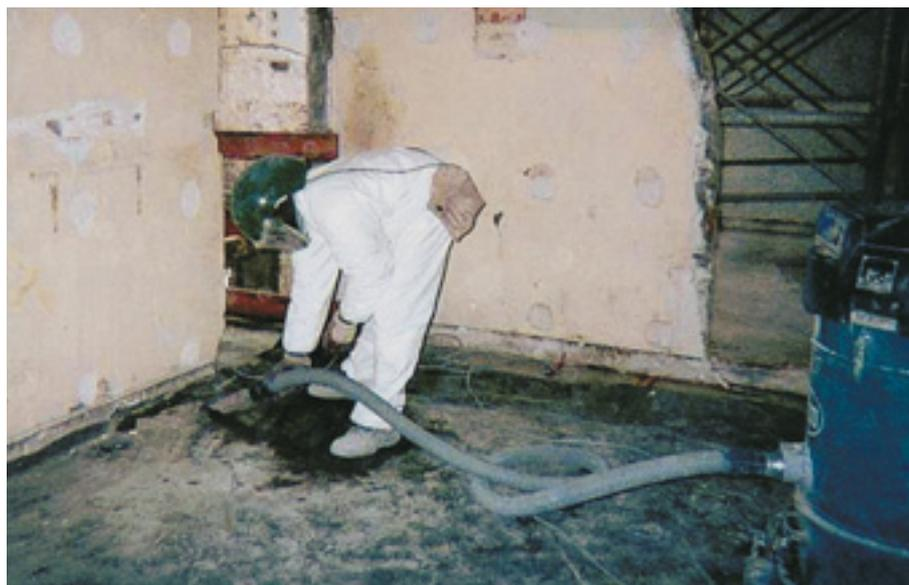
Un aspirateur avec filtre à très haute efficacité est un aspirateur industriel dont le filtre permet de retenir 99,99 % des particules.
