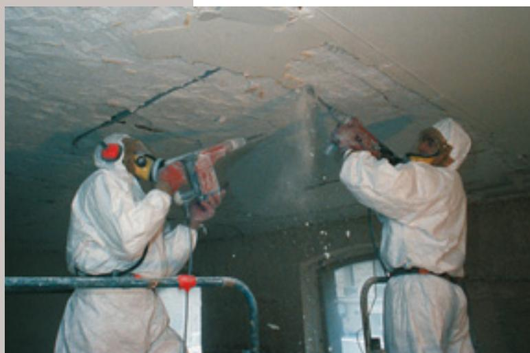
Sur les chantiers de rénovation et de démolition avec présence de peintures au plomb, les mesures de concentration en plomb dans l'atmosphère et d'empoussièremontrent que, dans la grande majorité des cas, il existe un risque plomb ou un risque poussières, ou les deux à la fois (par exemple, mesures réalisées par le laboratoire de toxicologie industrielle de la CRAMIF).
